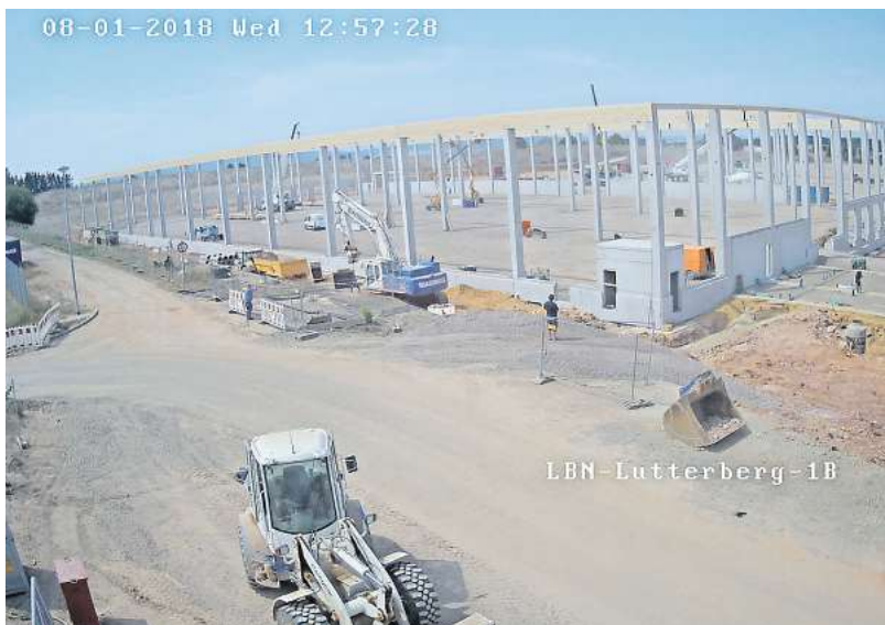
Screenshot einer Webcam, die den Baufortschritt des neuen Logistikzentrums dokumentiert. FOTO: LIST-BAU
